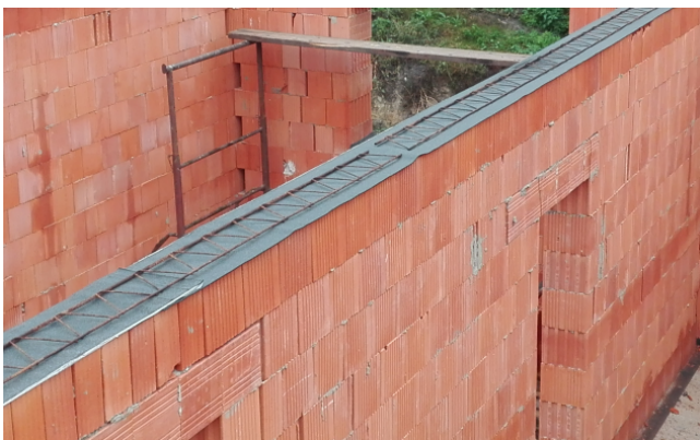
Obrázok 6 – Ochrana muriva pred poveternostnými vplyvmi
